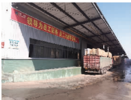
▲过道宽度极大地保障了一切畅通、高效
